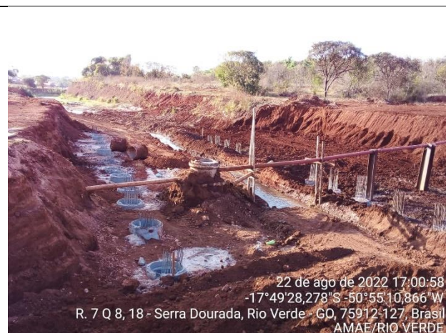
Autor: AMAE/RIO VERDE Descrição: Etapa de concretagem de colunas.
