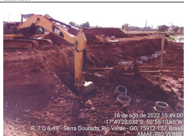
16 de ago de 2022 15:49:00 -17°49'28,032"S - 50°55'10,65"W R. 7 Q 8, 18 - Serra Dourada, Rio Verde - GO, 75912-127, Brasil AMAE/RIO VERDE Autor: AMAE/RIO VERDE Descrição: Escavação sendo realizada em torno do PV.
