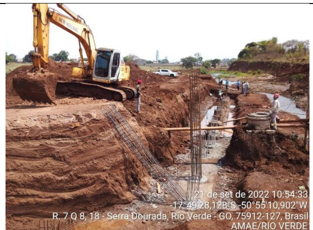
Autor: AMAE/RIO VERDE Descrição: Equipes da Secretaria de Infraestrutura na obra da ponte.
