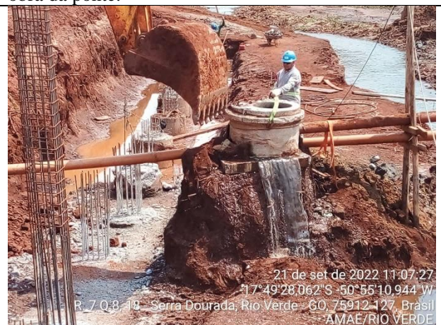
Autor: AMAE/RIO VERDE Descrição: Remoção do PV.
