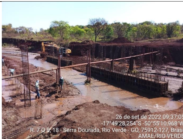
Autor: AMAE/RIO VERDE Descrição: Travessia após o reparo.
