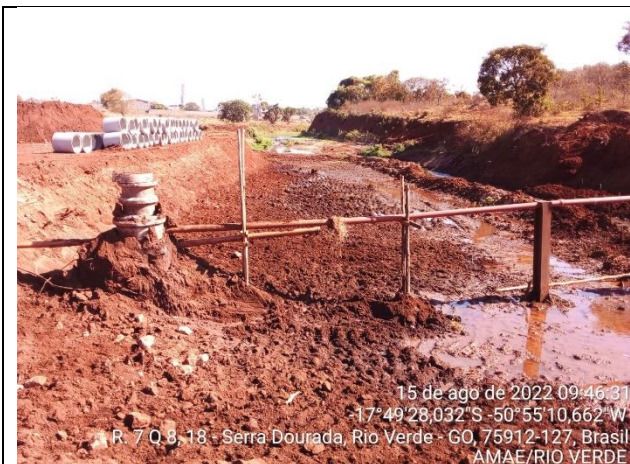
15 de ago de 2022 09:46:31 -17°49'28,032"S - 50°55'10,662"W R. 7 Q 8, 18 - Serra Dourada, Rio Verde - GO, 75912-127, Brasil AMAE/RIO VERDE Autor: AMAE/RIO VERDE Descrição: PV descoberto pelas escavações no seu entorno.
