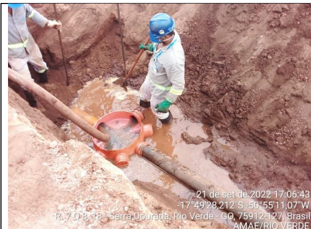
Autor: AMAE/RIO VERDE Descrição: Instalação do PV em novo local.
