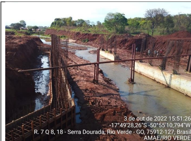
Autor: AMAE/RIO VERDE Descrição: Equipes da BRK trabalhando nos reparos da travessia, rompida devido à precipitação.
