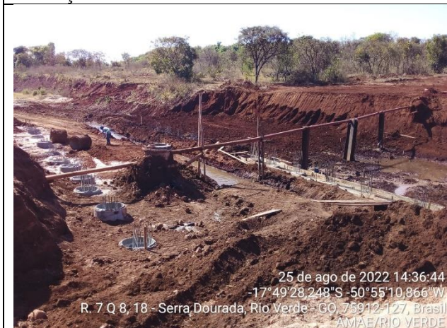
Autor: AMAE/RIO VERDE Descrição: Acompanhamento da obra.
